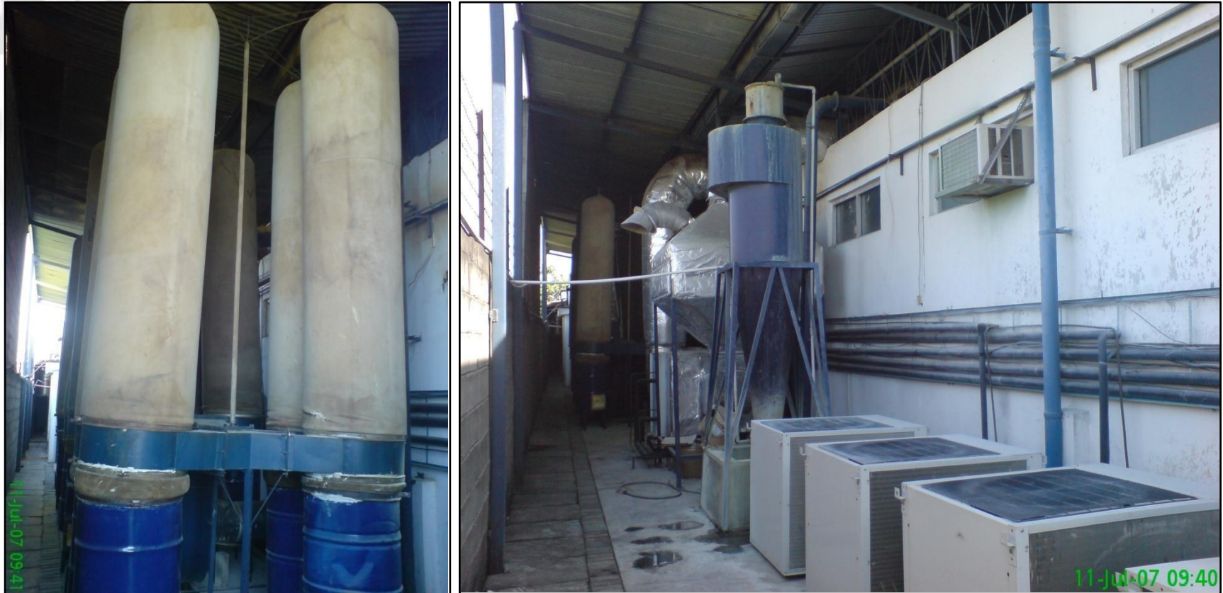
Pengelolaan limbah udara industri farmasi dengan dust collector
